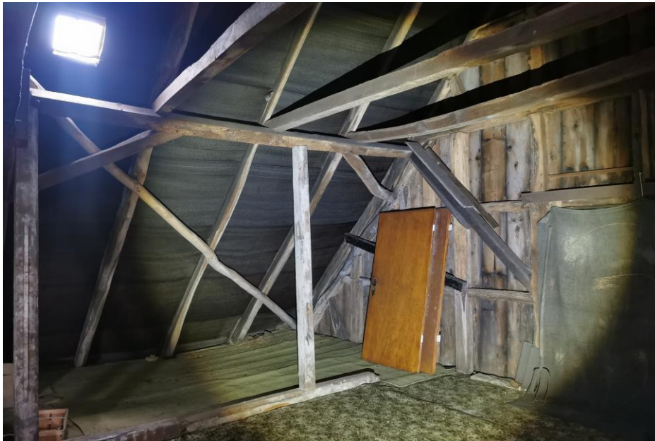
Abb. 15 Dachboden mit Bitumen-Zwischendecke
