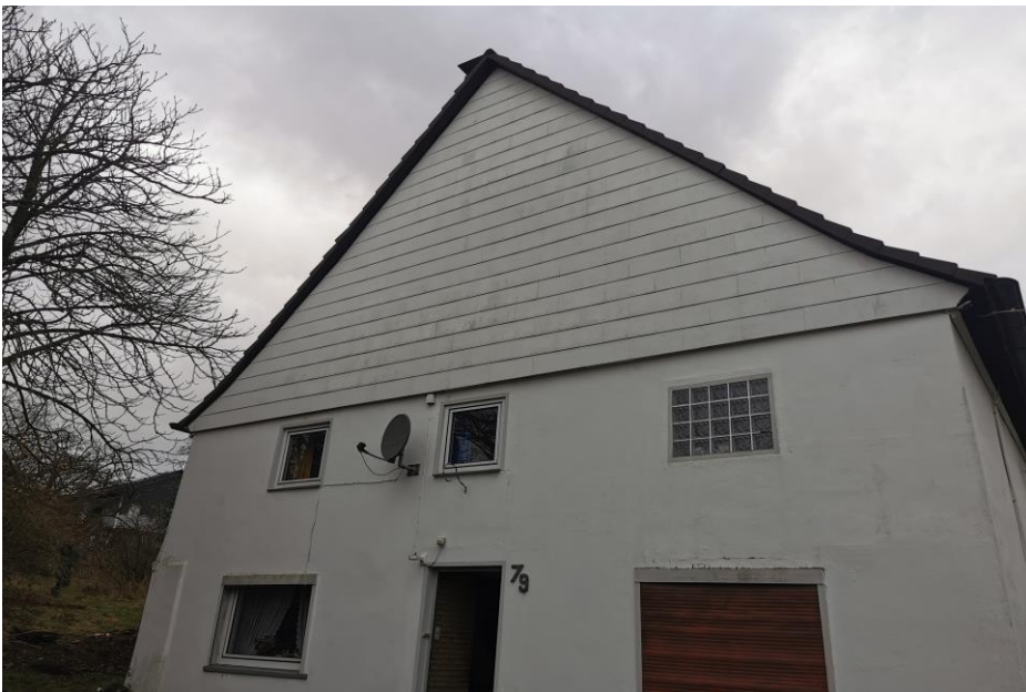
Abb. 10 Nordwestliches Bestandsgebäude (Front) mit Holzverschalung
