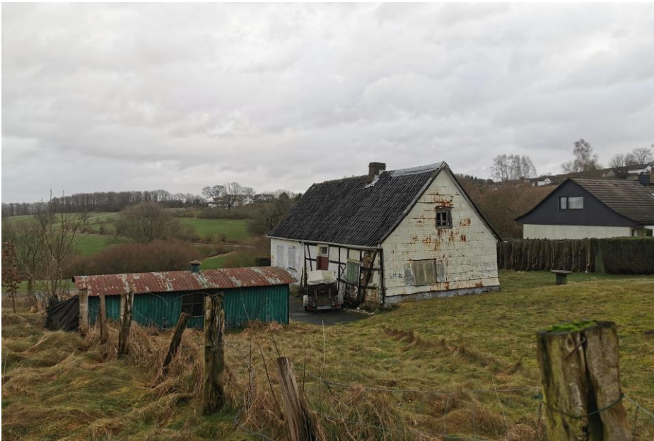
Abb. 9 Östliches Plangebiet und dortiges Bestandsgebäude (kein Zugang möglich, konnte nur von außen begutachtet werden)
