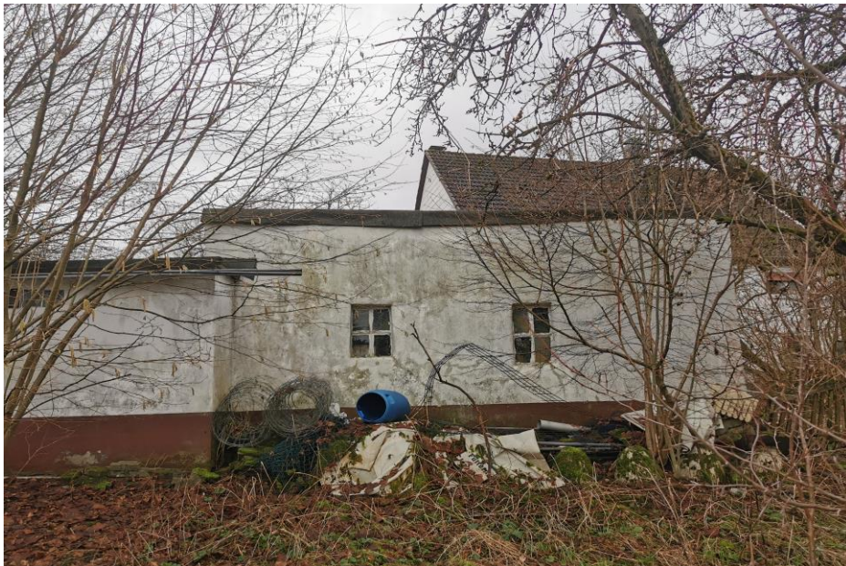
Abb. 18 Schuppen und Garage (Rückseite)
