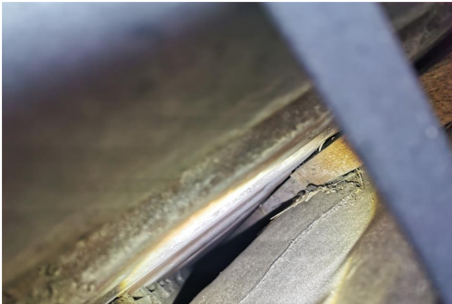
Abb. 16 Blick in die Zwischendecke
