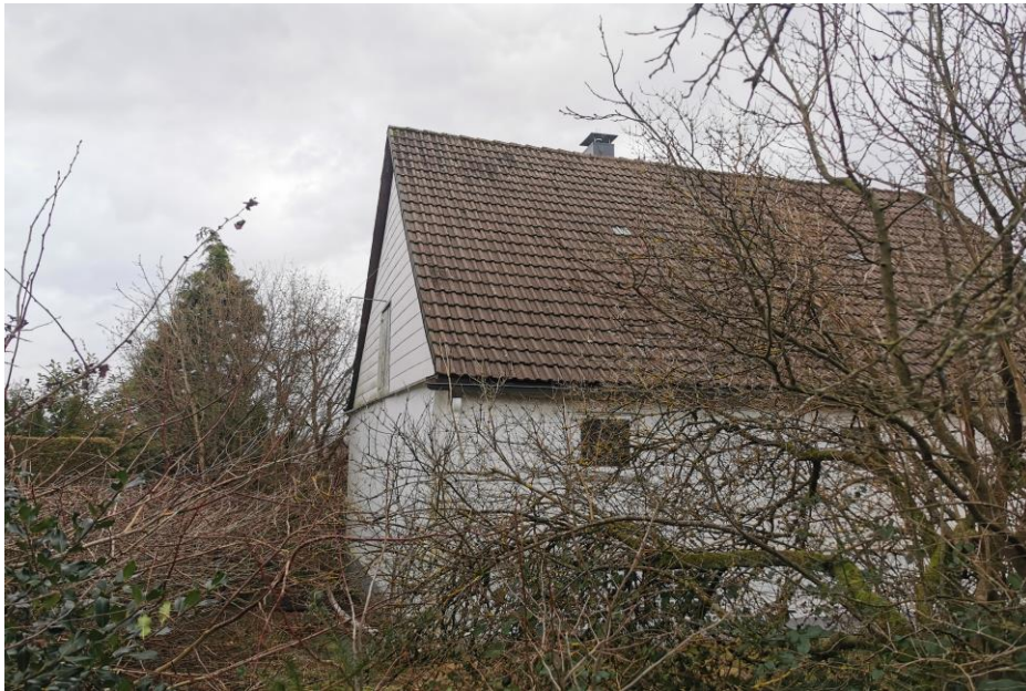
Abb. 11 Nordwestliches Bestandsgebäude (Rückseite) mit Holzverschalung
