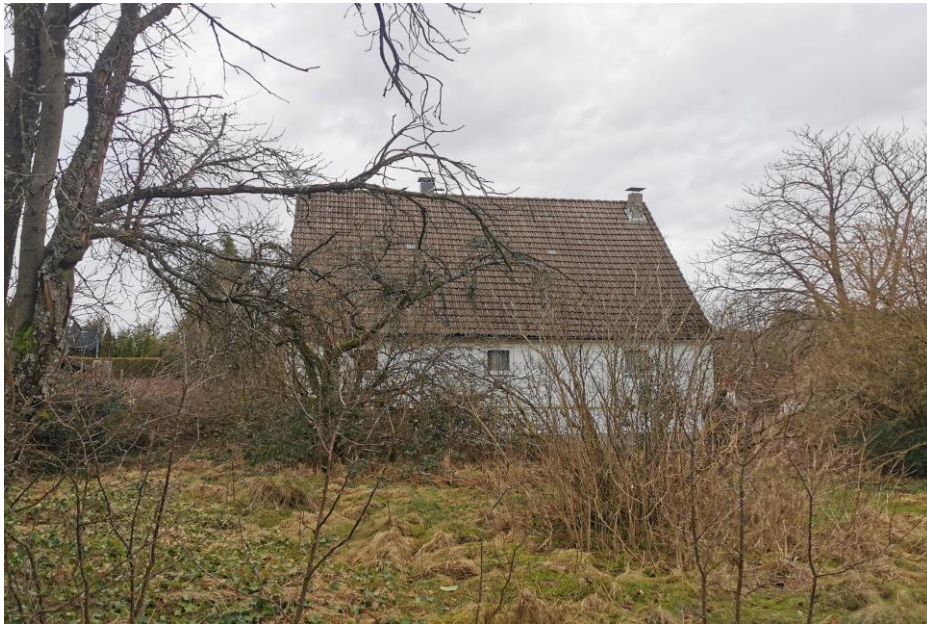
Abb. 5 Westliches Plangebiet und nordwestliches Bestandsgebäude
